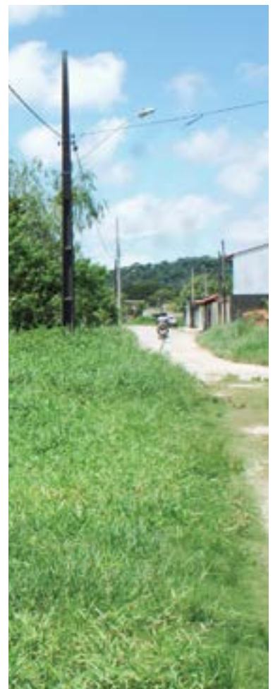
A vala está incoberta pelo mato, que chega a invadir a rua
